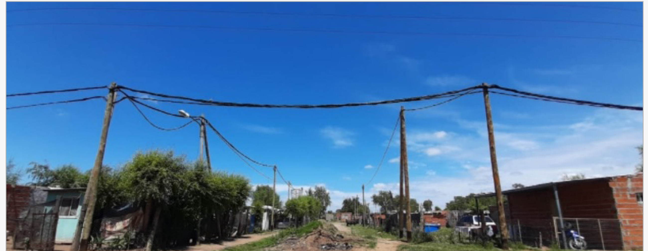
Obra Barrio Los Totoreros Junín
